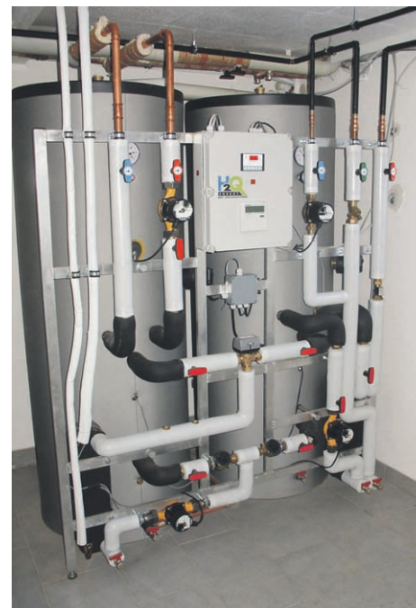
Bild links: Das H2Q Heiz- und Kühlsystem besteht aus einer kompakten, außen aufgestellten Split-Wärmepumpe sowie einem Energiespeichersystem im Gebäude. Beide Komponenten werden über dünne Kältemittelrohre miteinander verbunden. Das Bild zeigt ein H2Q-Energiespeichersystem im Gebäude (H2Q-ES-400). Bild rechts: Heizungsmodernisierung im Einfamilienhaus. Eine 10-kW-Anlage. Aufstellung der Split-Wärmepumpe (H2Q-1000) im Freien. Bild unten: Referenzanlage bei Dekra in Möhringen. Eine 90-kW-Anlage. Aufstellung der Split-Wärmepumpen (H2Q-9000) in Kaskade.
