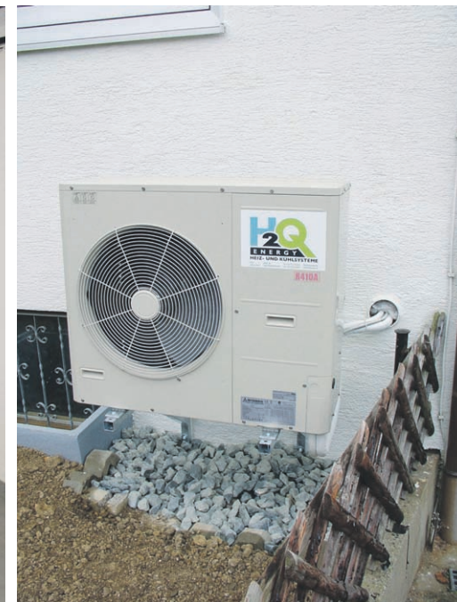
Bild links: Das H2Q Heiz- und Kühlsystem besteht aus einer kompakten, außen aufgestellten Split-Wärmepumpe sowie einem Energiespeichersystem im Gebäude. Beide Komponenten werden über dünne Kältemittelrohre miteinander verbunden. Das Bild zeigt ein H2Q-Energiespeichersystem im Gebäude (H2Q-ES-400). Bild rechts: Heizungsmodernisierung im Einfamilienhaus. Eine 10-kW-Anlage. Aufstellung der Split-Wärmepumpe (H2Q-1000) im Freien. Bild unten: Referenzanlage bei Dekra in Möhringen. Eine 90-kW-Anlage. Aufstellung der Split-Wärmepumpen (H2Q-9000) in Kaskade.
