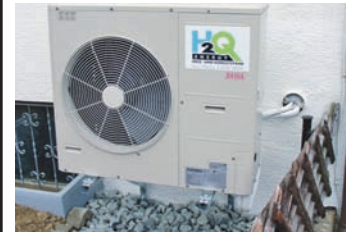
Referenzanlage – Heizungsmodernisierung im Einfamilienhaus, 10-kW-Anlage – Aufstellung der Split-Wärmepumpe (H2Q-1000) im Freien
